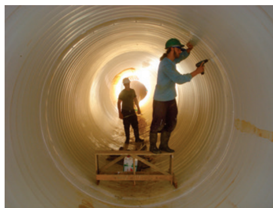
Fase 5 final : Fixação com rebites *Fixação adicional com rebites.
