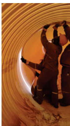
Fase 4: Instalação da luva *Posicionar com a curva na parte inferior e pressionar a luva.
