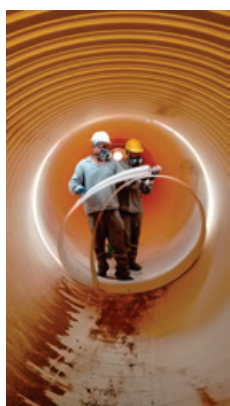
Fase 3: Instalação da luva *Iniciar posicionamento da luva.
